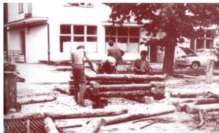
Строительство детской дворовой площадки
